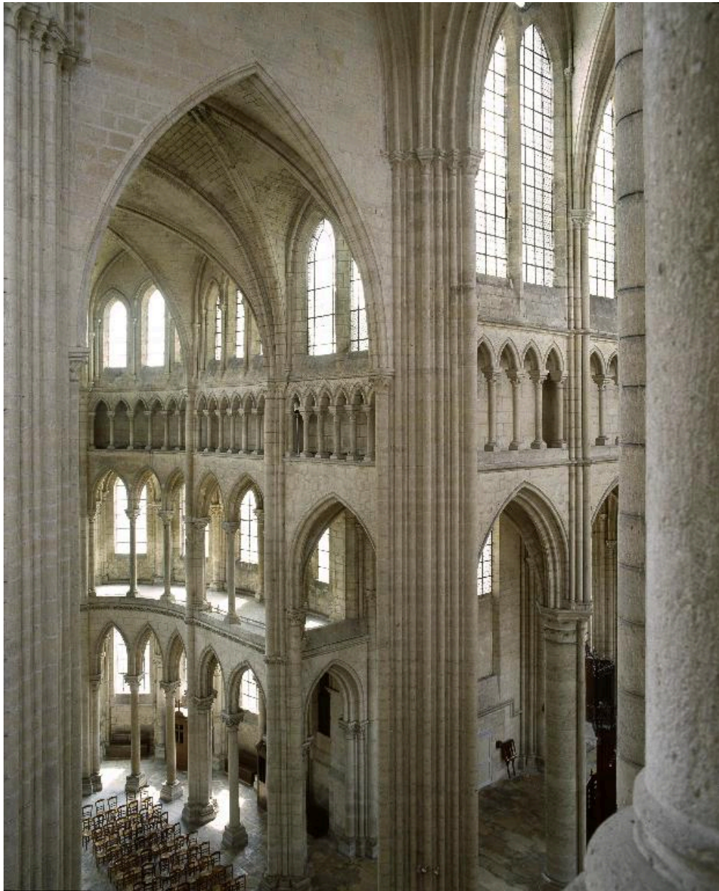
Vue du bras sud du transept.
