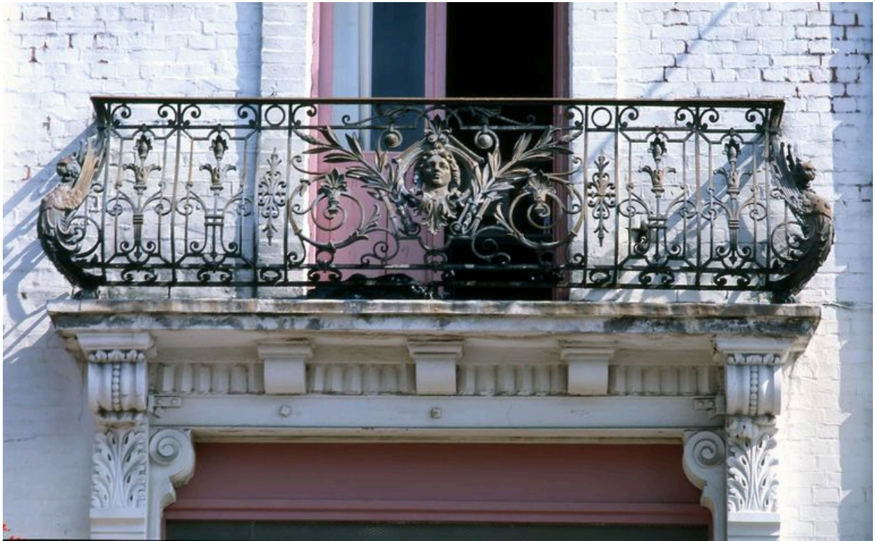
Détail d'un garde-corps en fonte en façade principale.
