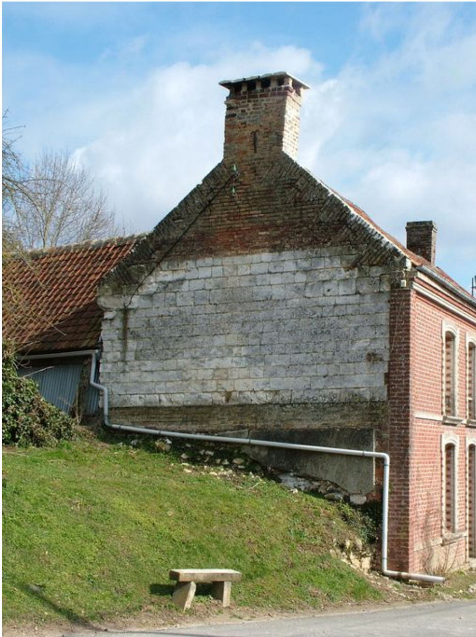
Vue du pignon extérieur du logis.
