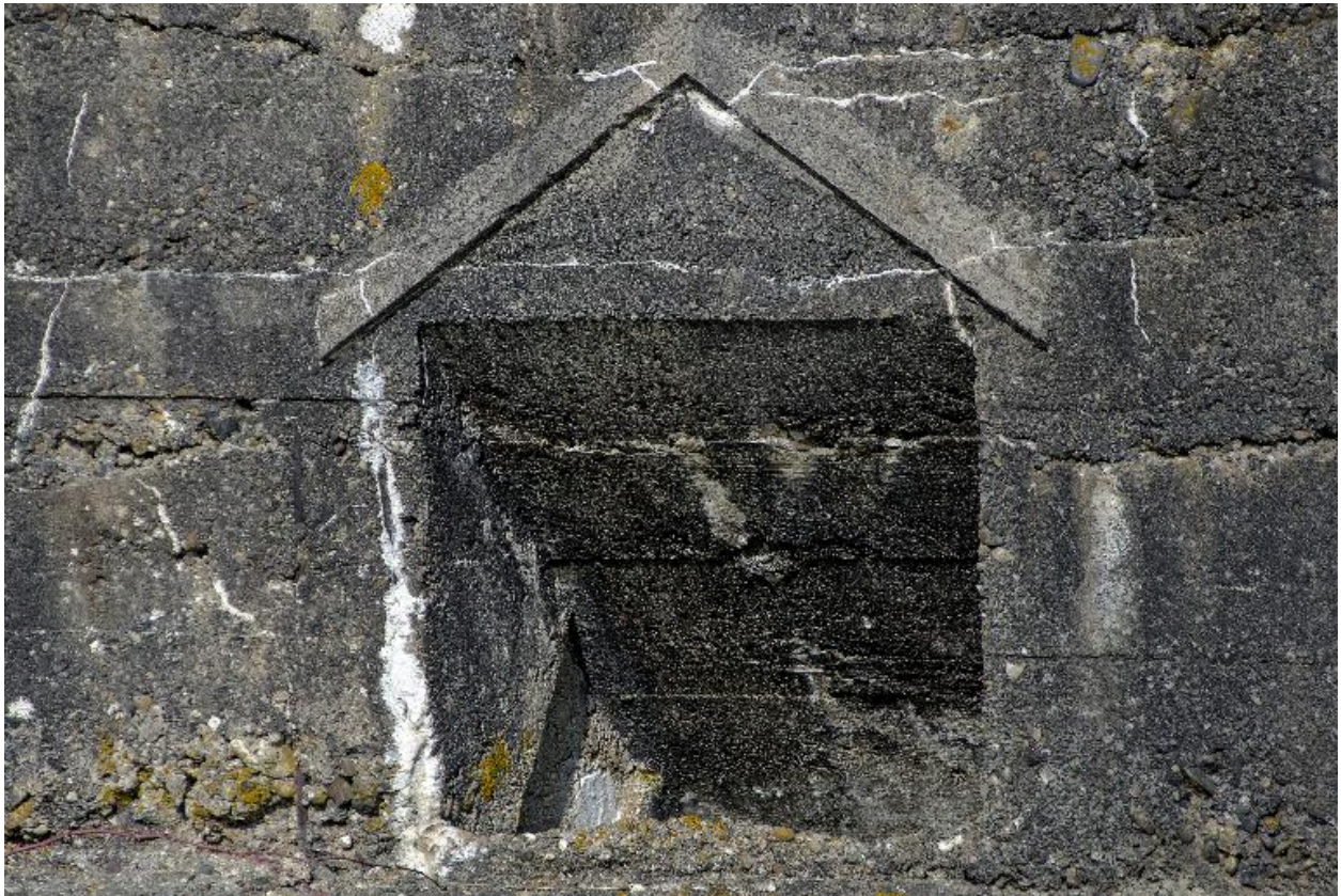
Elévation sud. Conduit biais descendant dans l'abri. (Aération ?)
