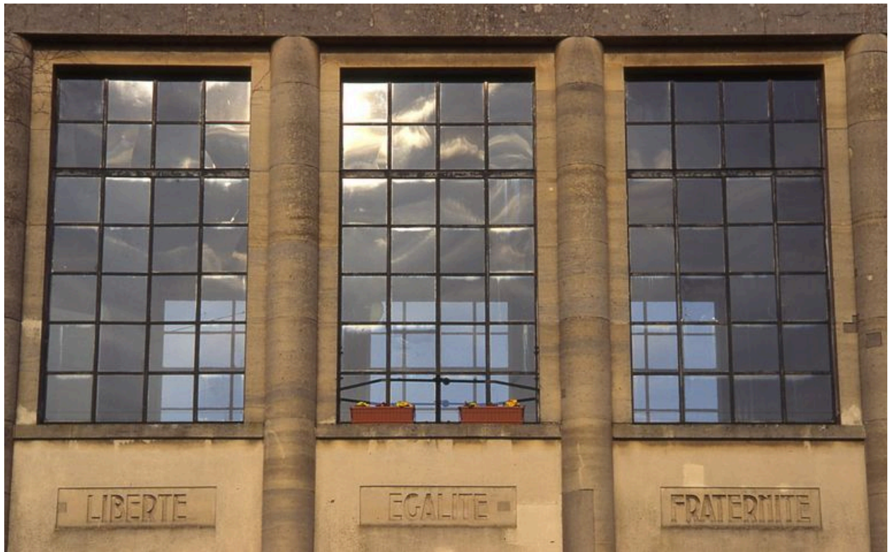
Détail des fenêtres de la façade.
