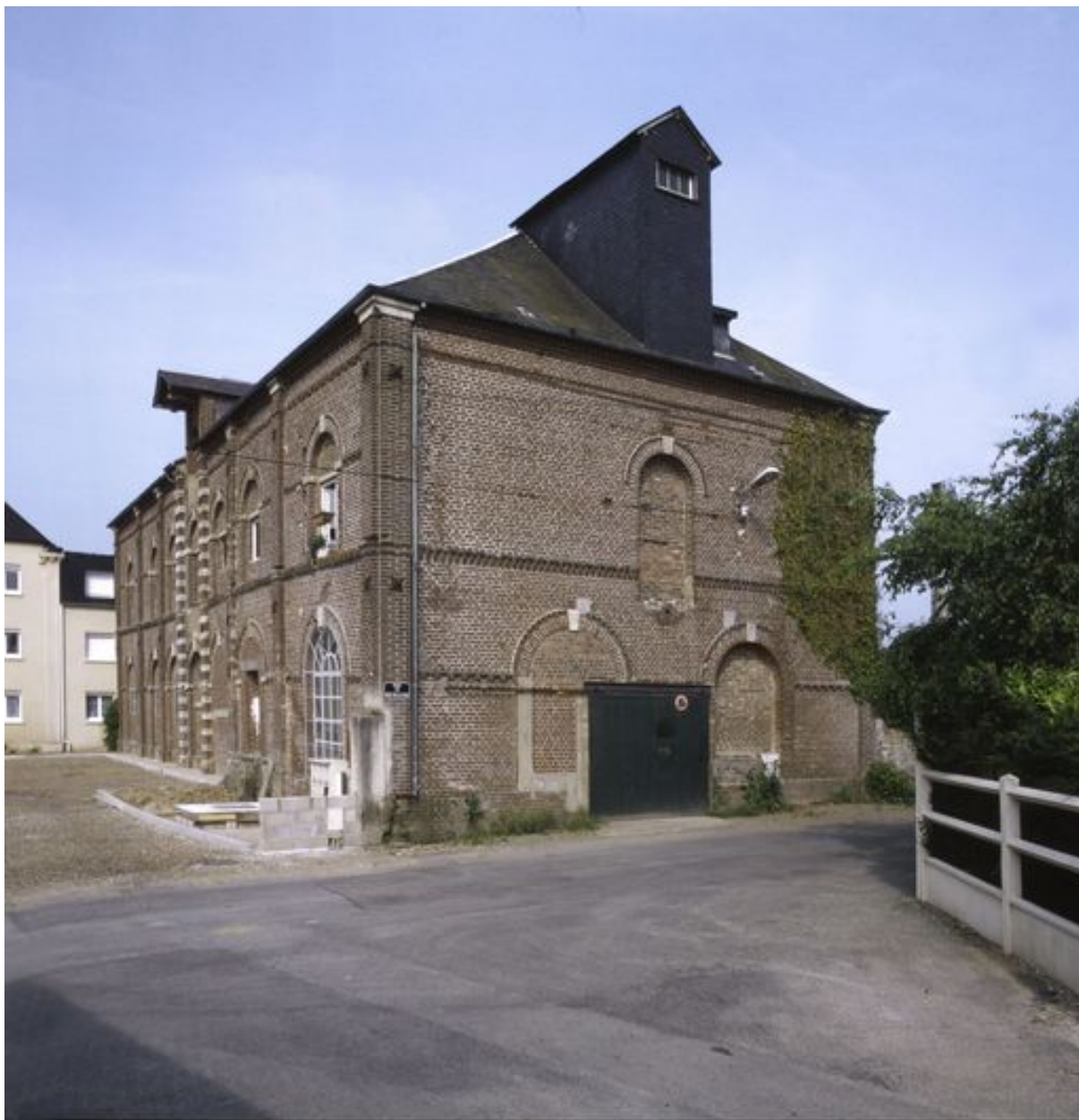
Vue d'ensemble nord-ouest de l'atelier de fabrication.
