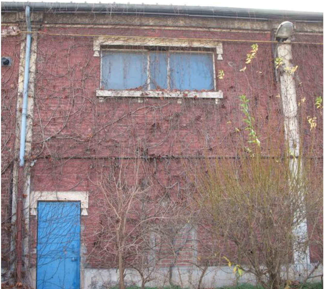
Détail de l'une des travées du mur nord de la salle des fêtes.
