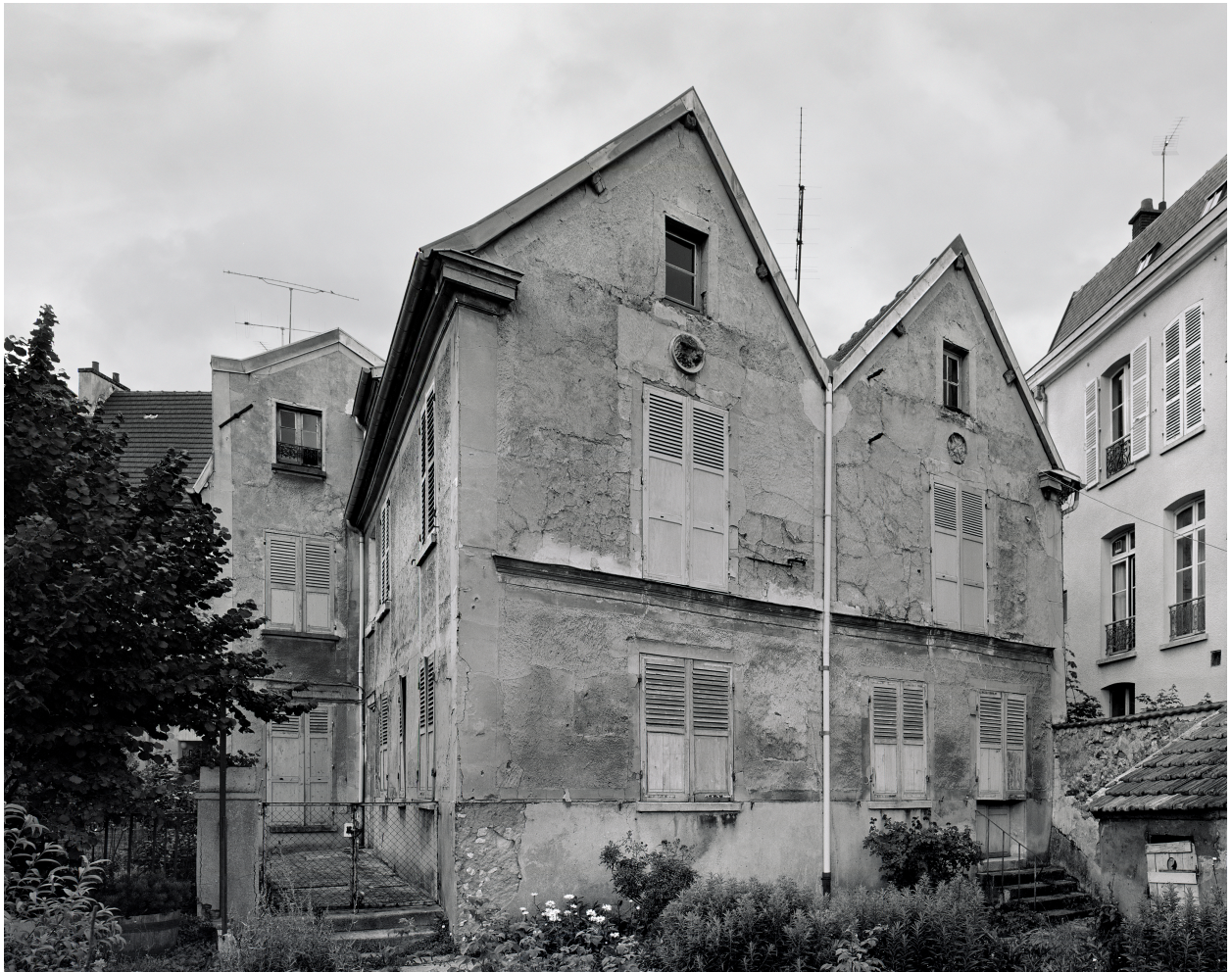
Vue des pignons sur le jardin.
