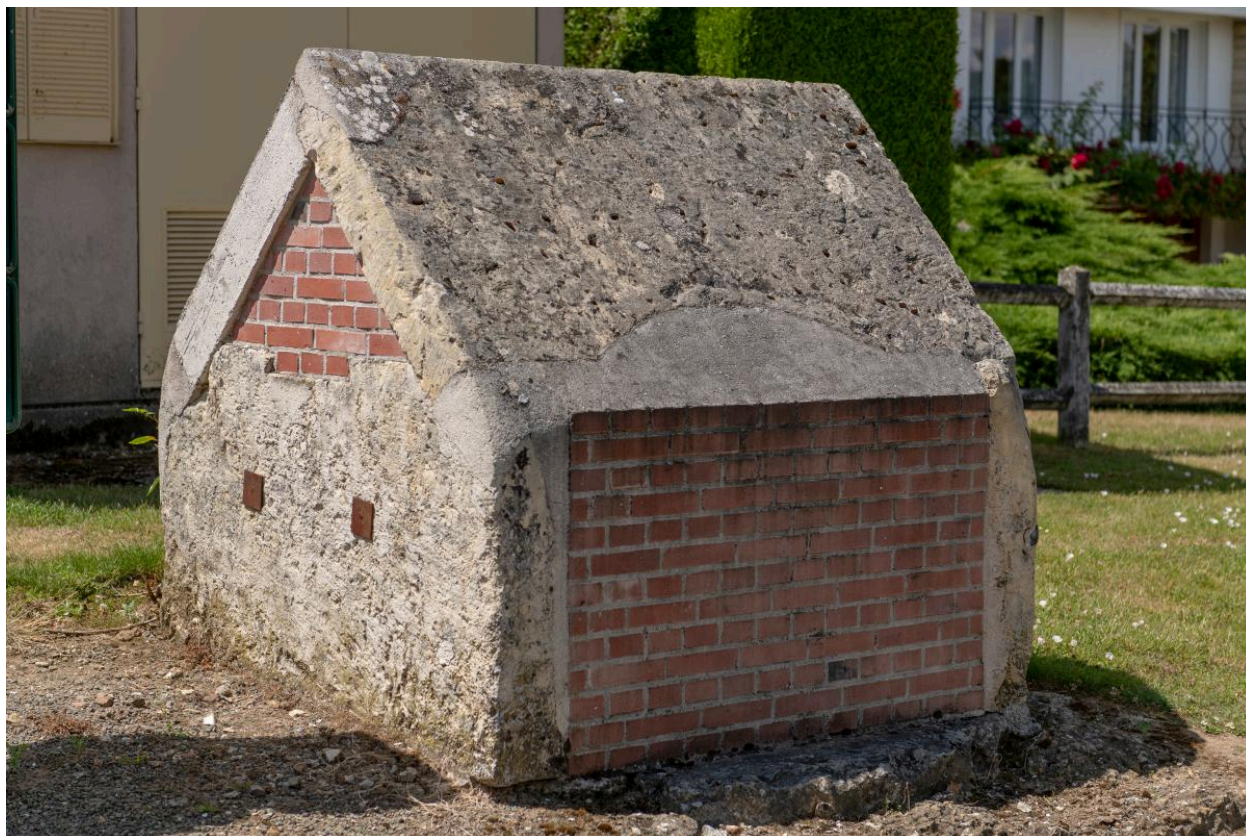
Puits restauré, rue Bois l'Abbé, vue depuis le nord.
