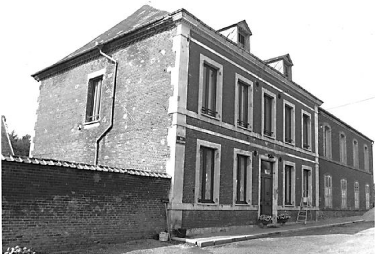
Vue depuis le nord-est.
