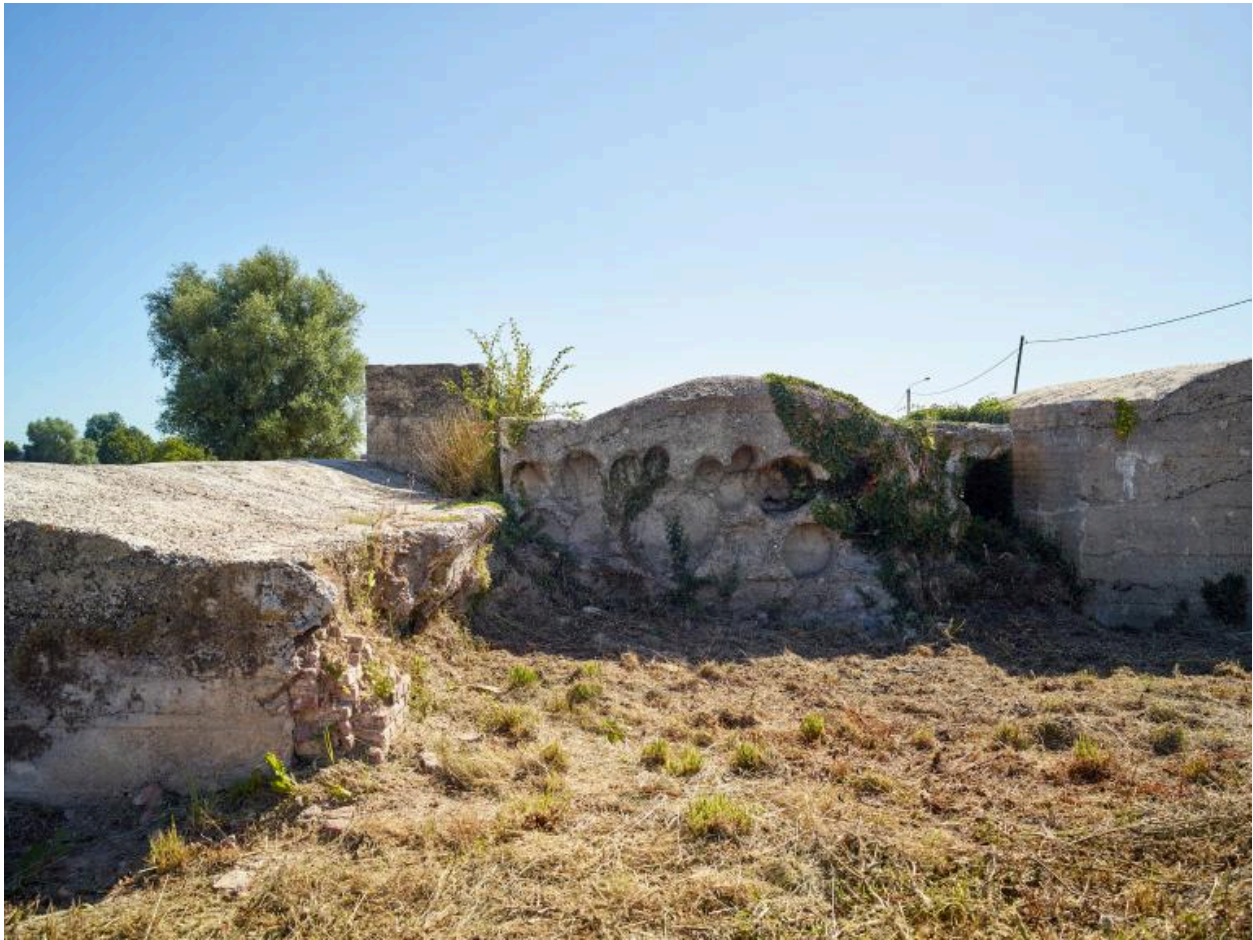
Traces de billes de bois sur la partie postérieure de la casemate d
