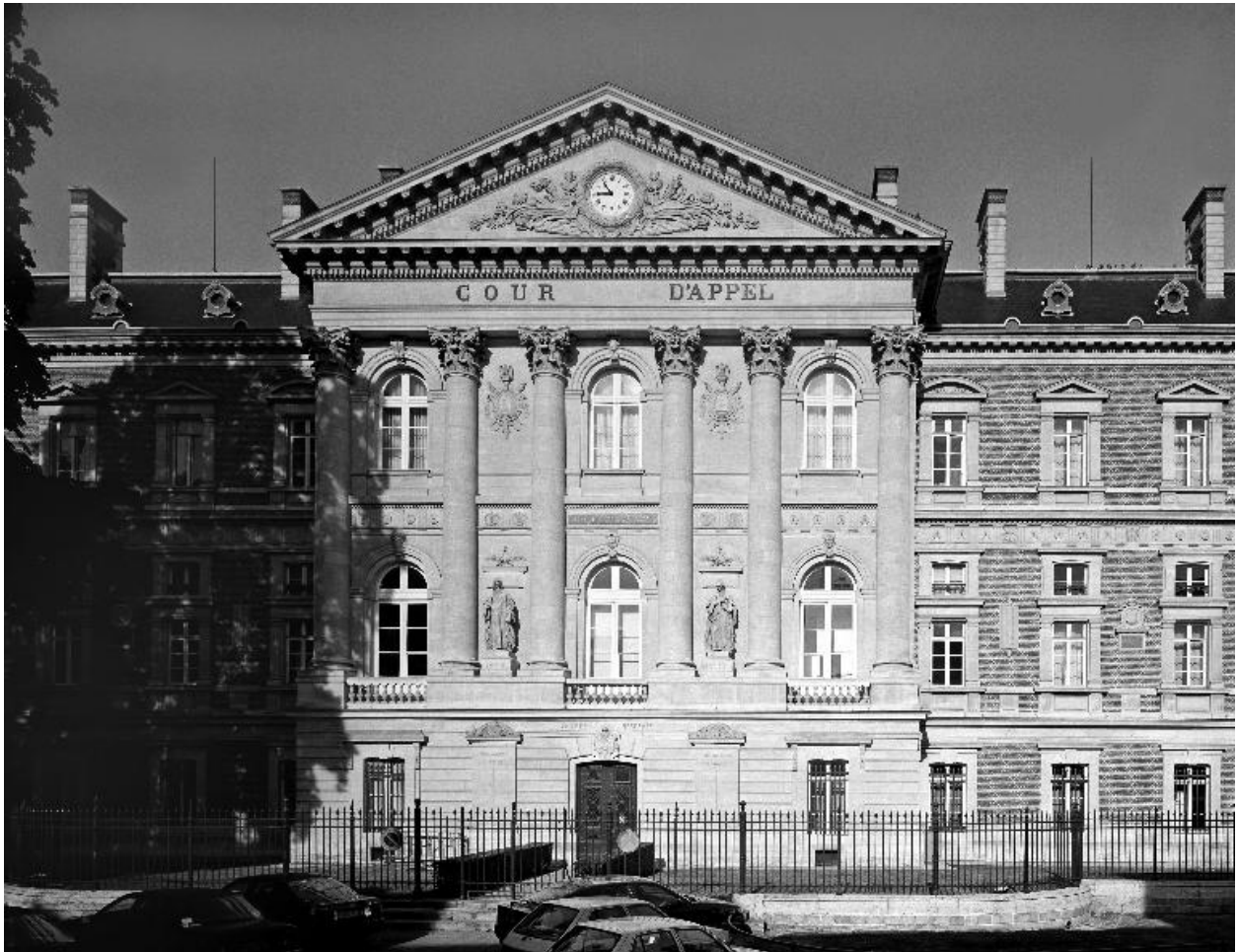
Détail sur le portique de la façade orientale.
