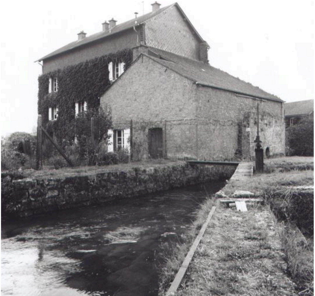
Vue d'ensemble postérieure.
