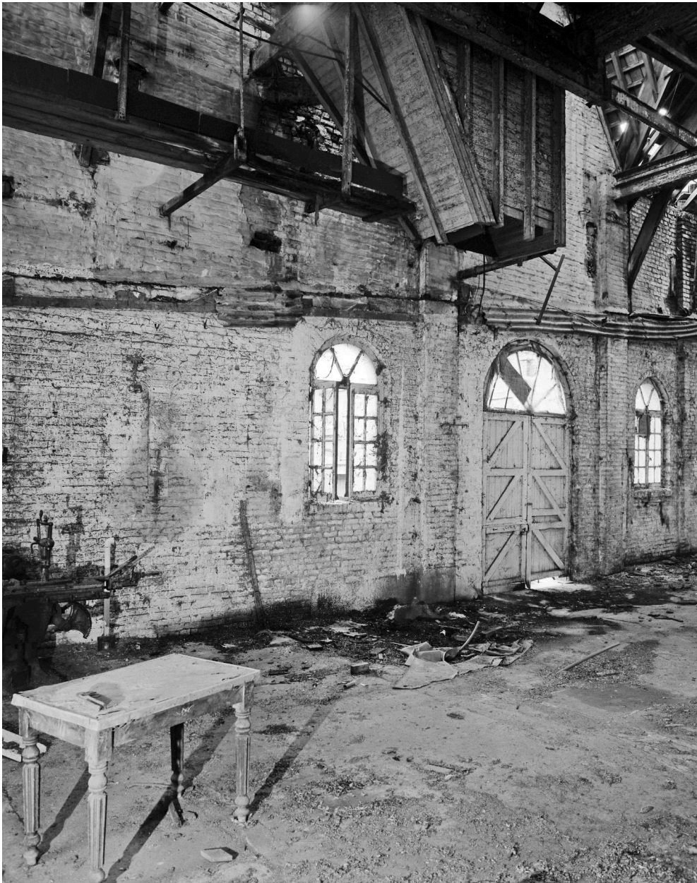
Vue intérieure de la brasserie. Descente de trémie.
