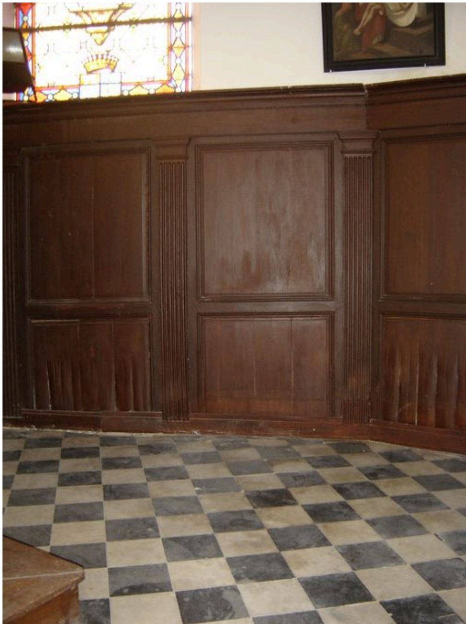
Vue du lambris de demi-revêtement dans le chœur.
