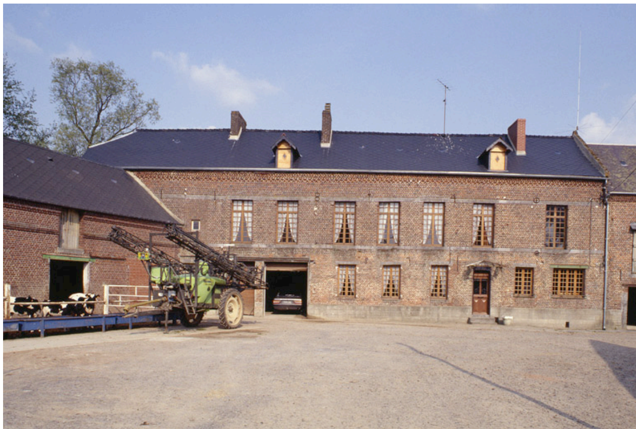
Façade du logis.
