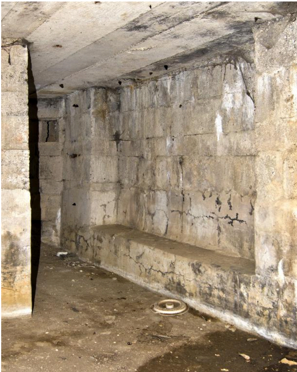
Vue intérieure. Passage entre les deux salles et grande niche, à droite
