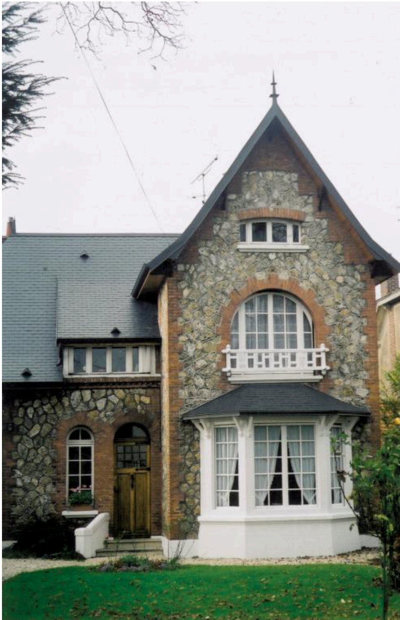
Maison, 62 rue Joliot-Curie.
