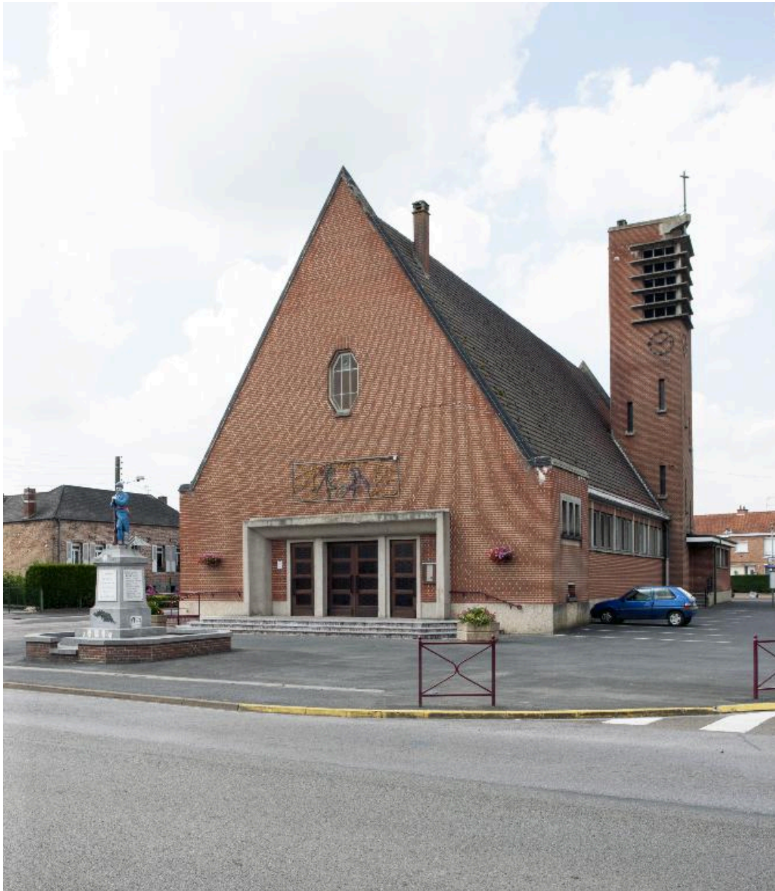
Vue de trois quarts droite de l'élévation antérieure.
