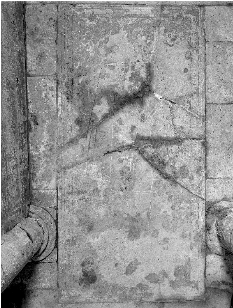
Vue générale de la dalle.
