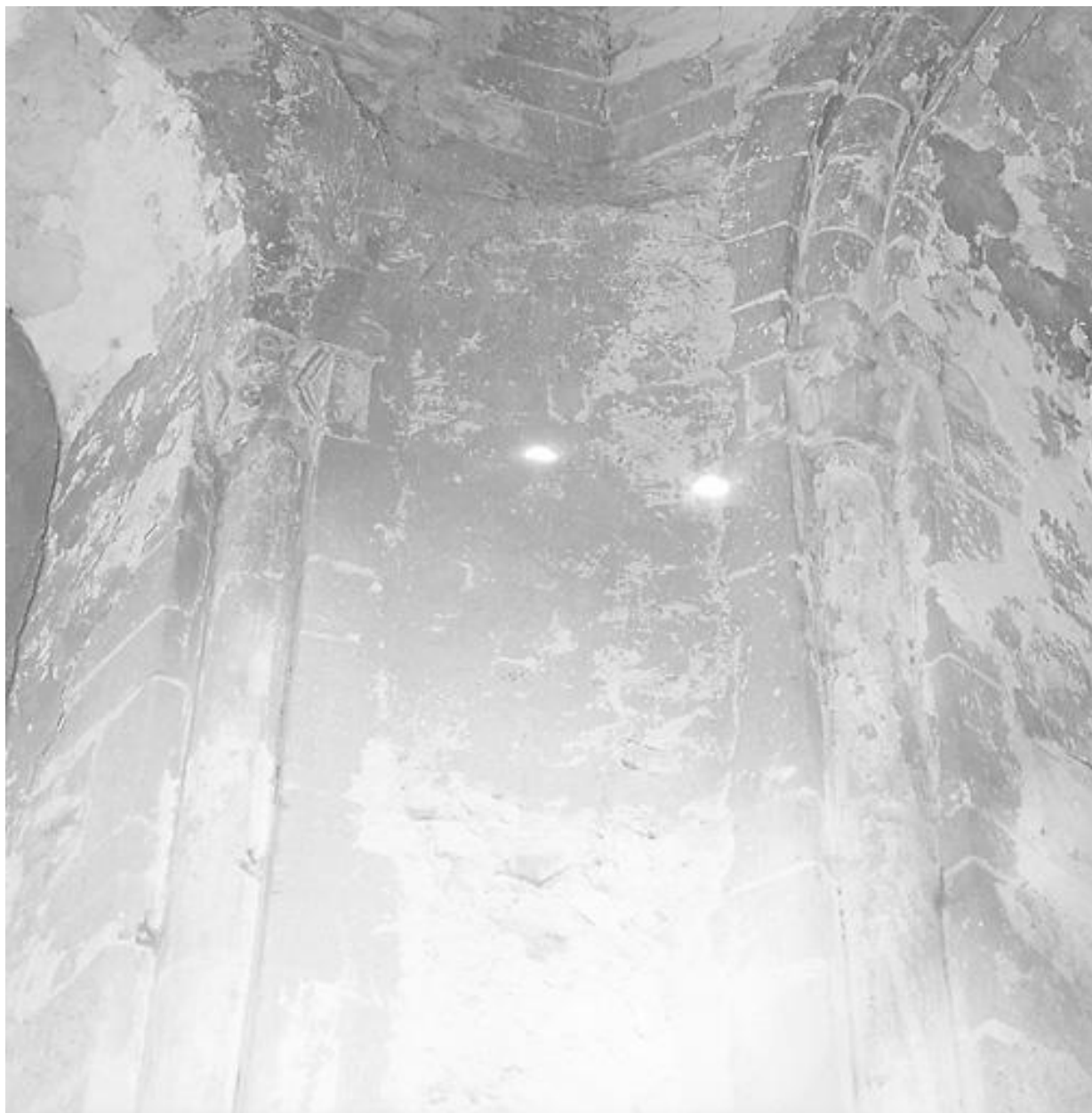
Bâtiment dans la cour, entrée 5 rue Henry, abside, angle nord, chapiteaux.
