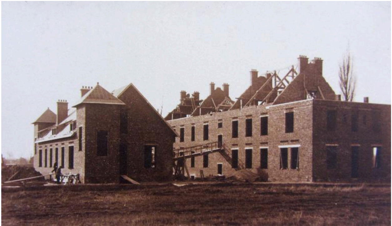
La cantine et les cuisines en cours de construction, 11 mars 1921 (AD Somme ; 49 Fi 47).
