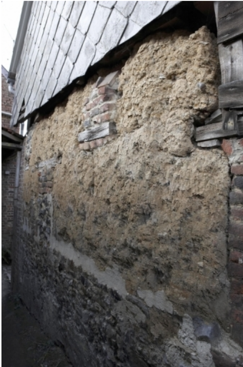
Détail de la maçonnerie du pignon est de la grange.
