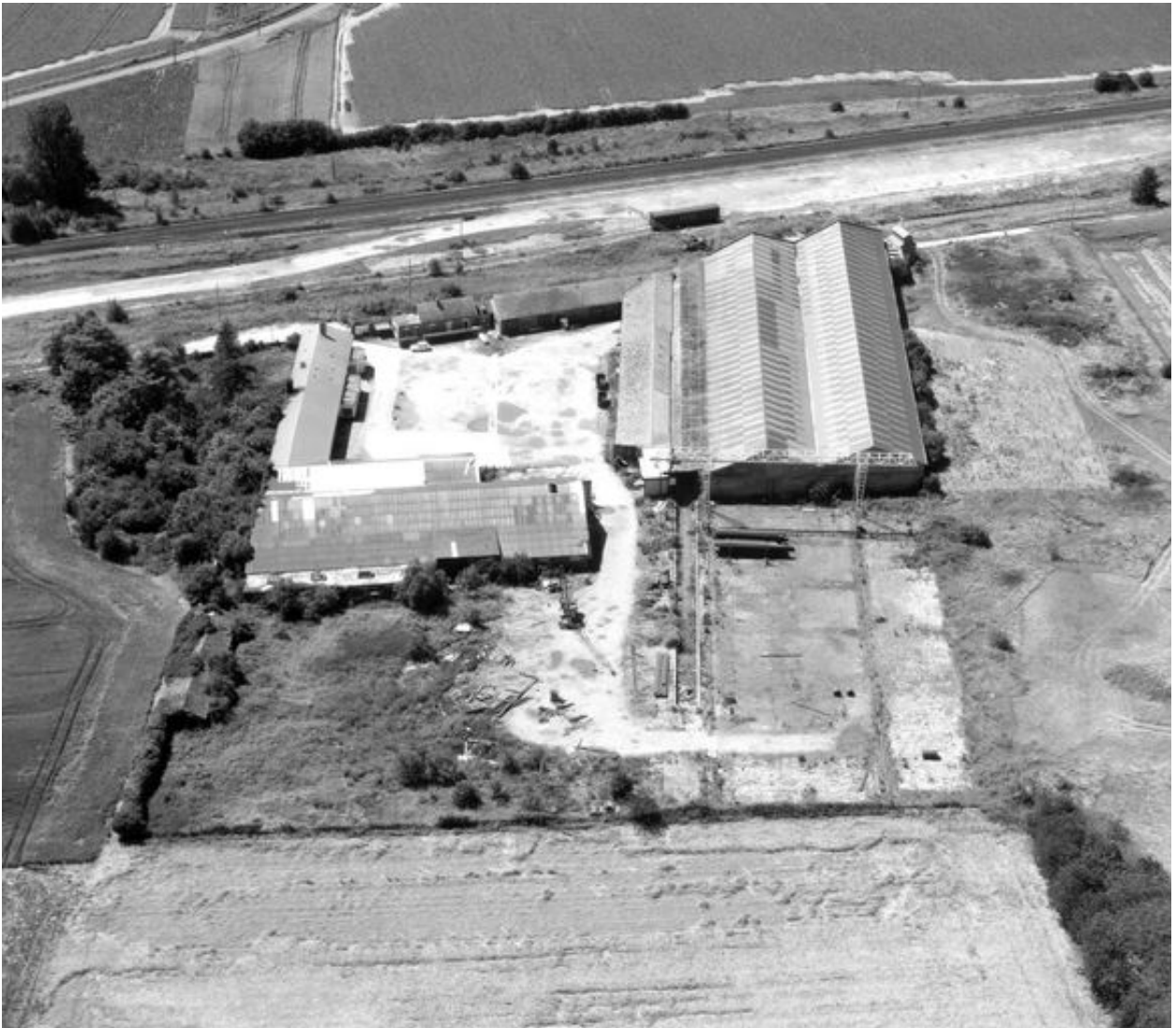
Vue aérienne, flanc nord.
