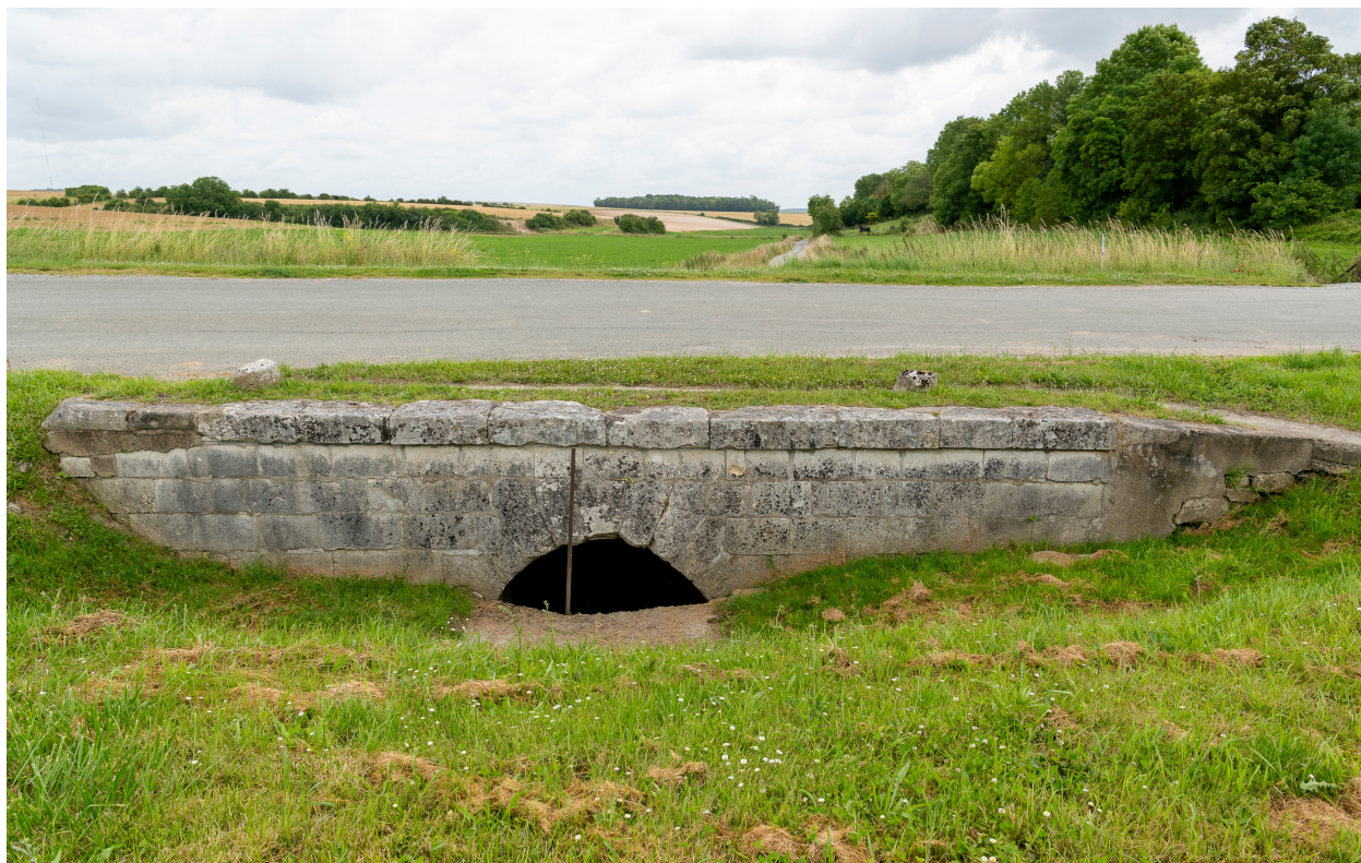
Pont de l'ancienne route Amiens-Beauvais, sortie nord.
