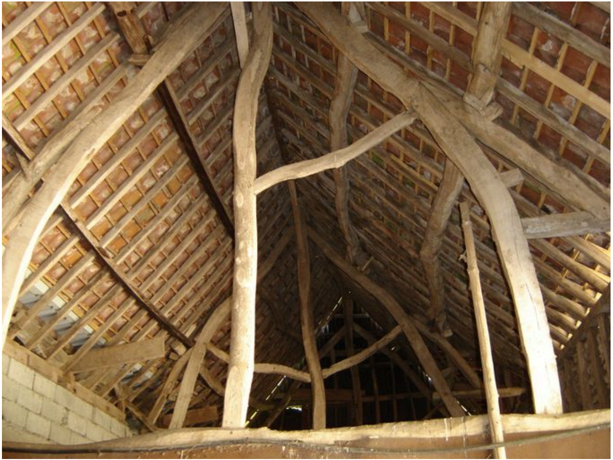
Vue de la charpente de la grange.
