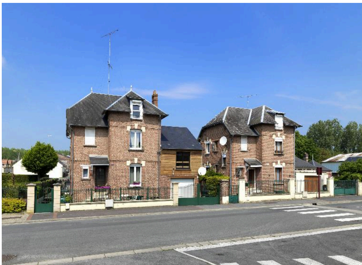
Vue d'ensemble sur rue des deux maisons d'ingénieur.
