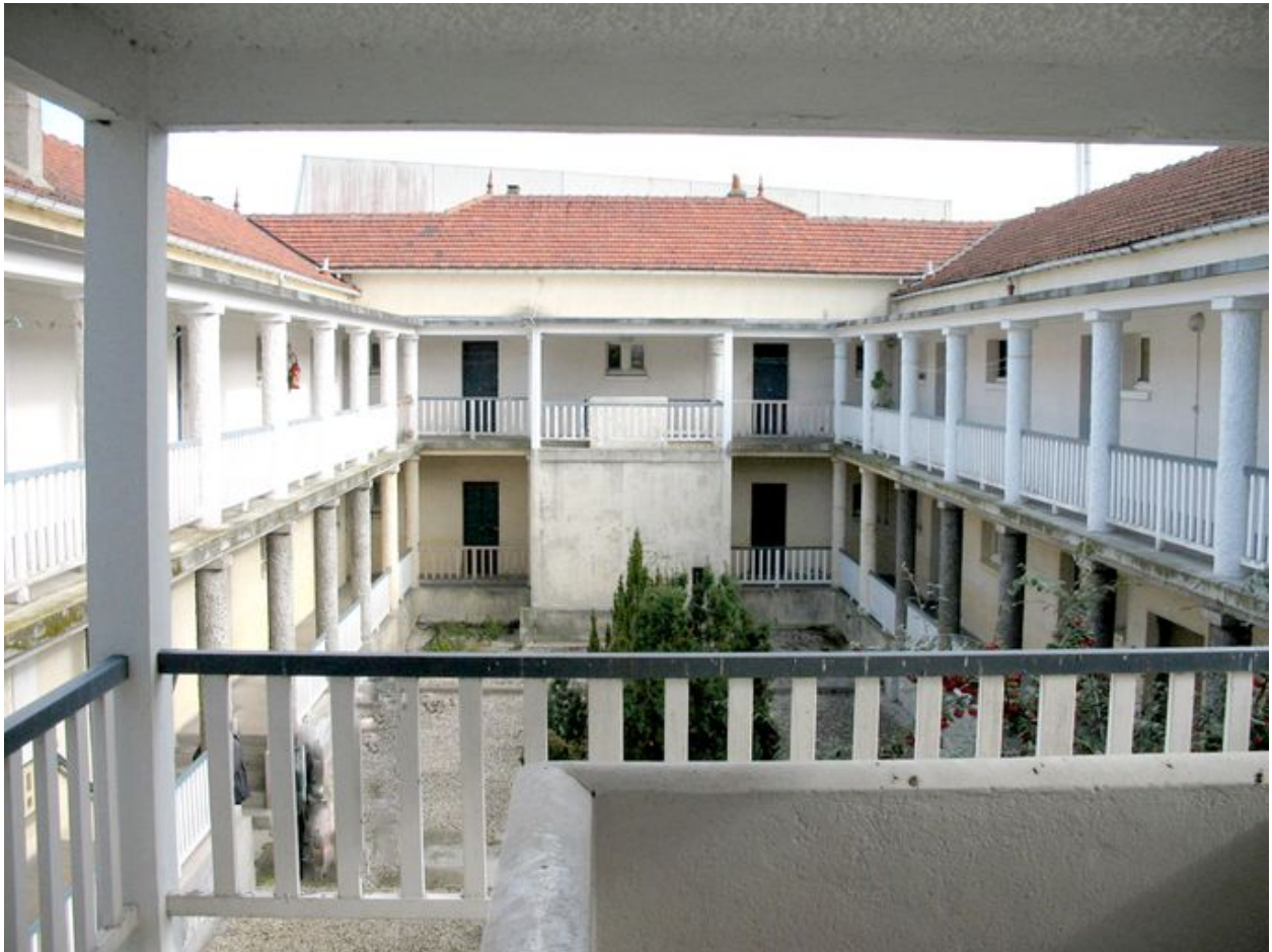
Bâtiment 520 : Cour intérieure du bâtiment pour ouvriers célibataires.
