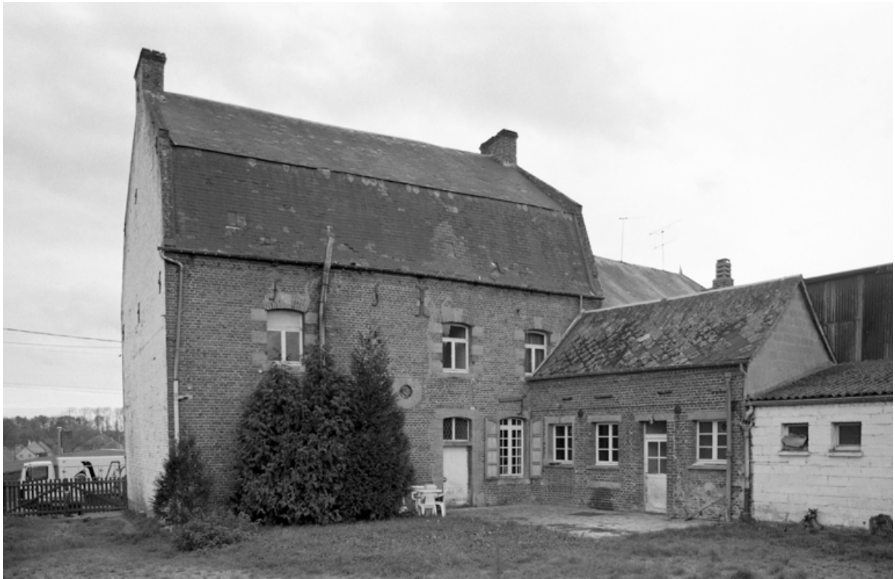
Elévation sur cour du logis.
