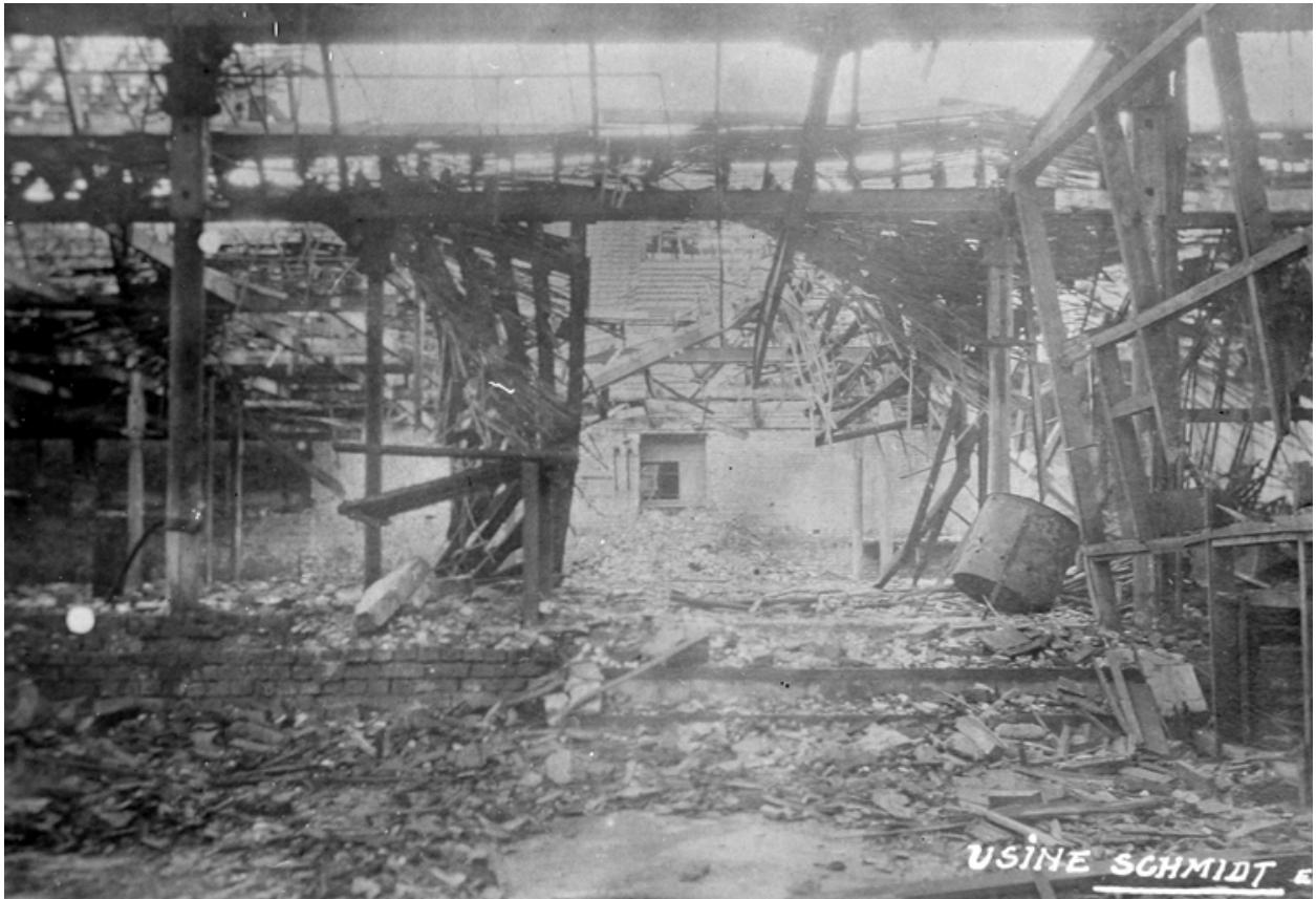
Usine Schmidt & Cie - Salle de montage des tours - (reproduction d'une photographie remise par M. Schmidt en 1919) - Brassart-Mariage architecte (AD Aisne).
