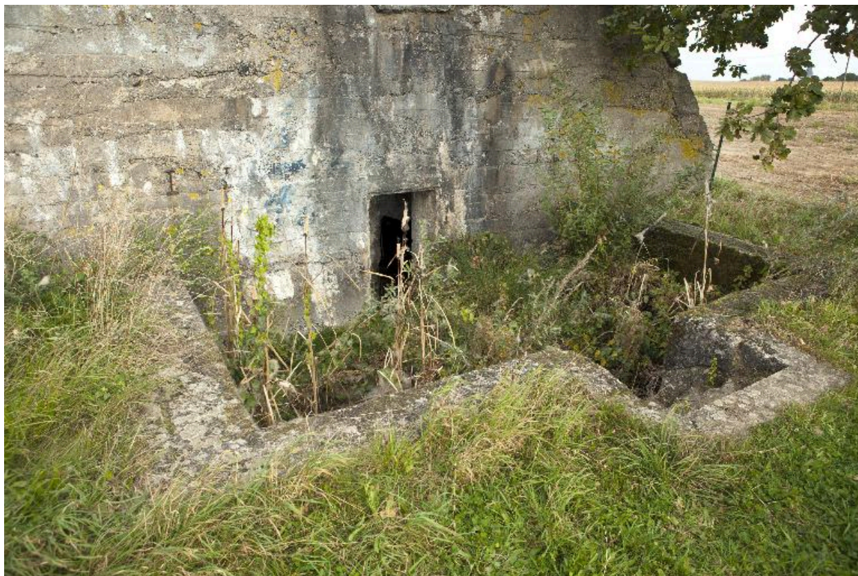
Élévation sud. Détail de la cour
