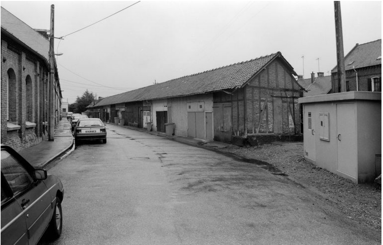
Vue des remises en regard des logements, en 1991.
