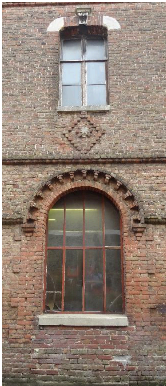
Détail des baies de l'atelier de fabrication.
