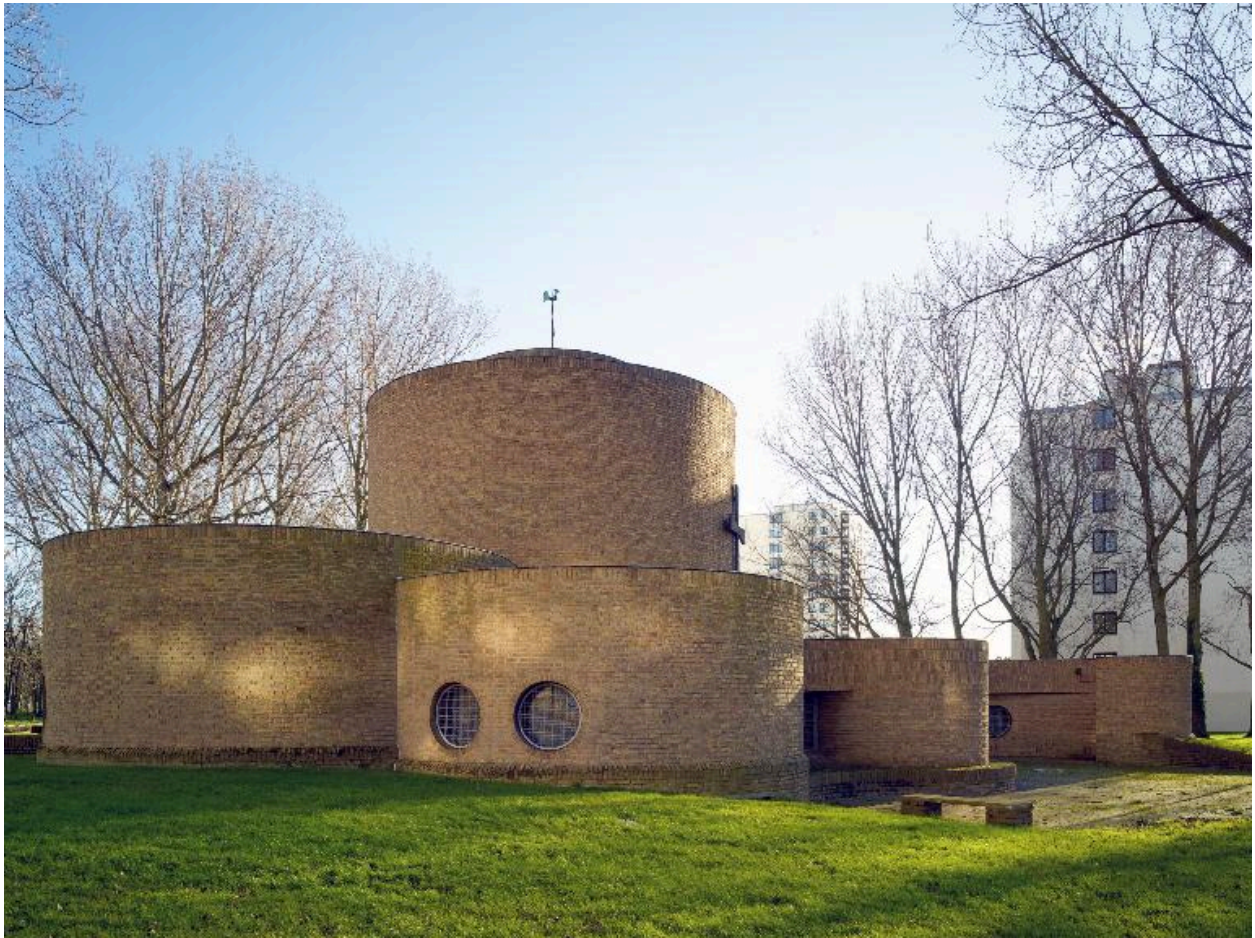
Élévation de la chapelle, côté nord ouest
