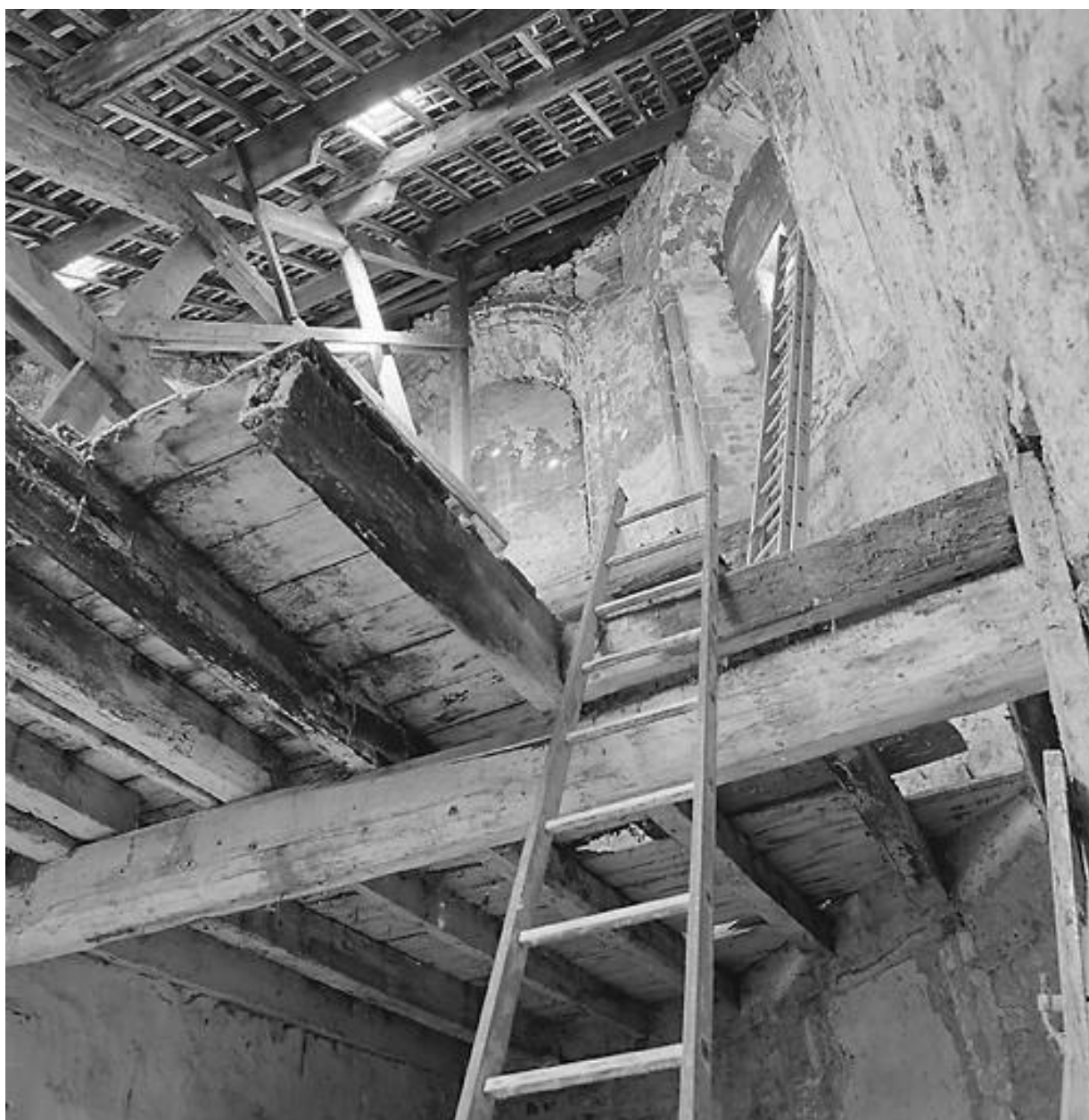
Bâtiment dans la cour, entrée 5 rue Henri : vue générale du rez-de-chaussée vers abside.
