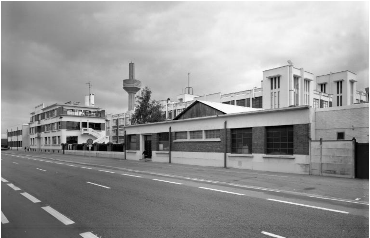
Élévation rue du Général De Gaulle, vers le sud-est.
