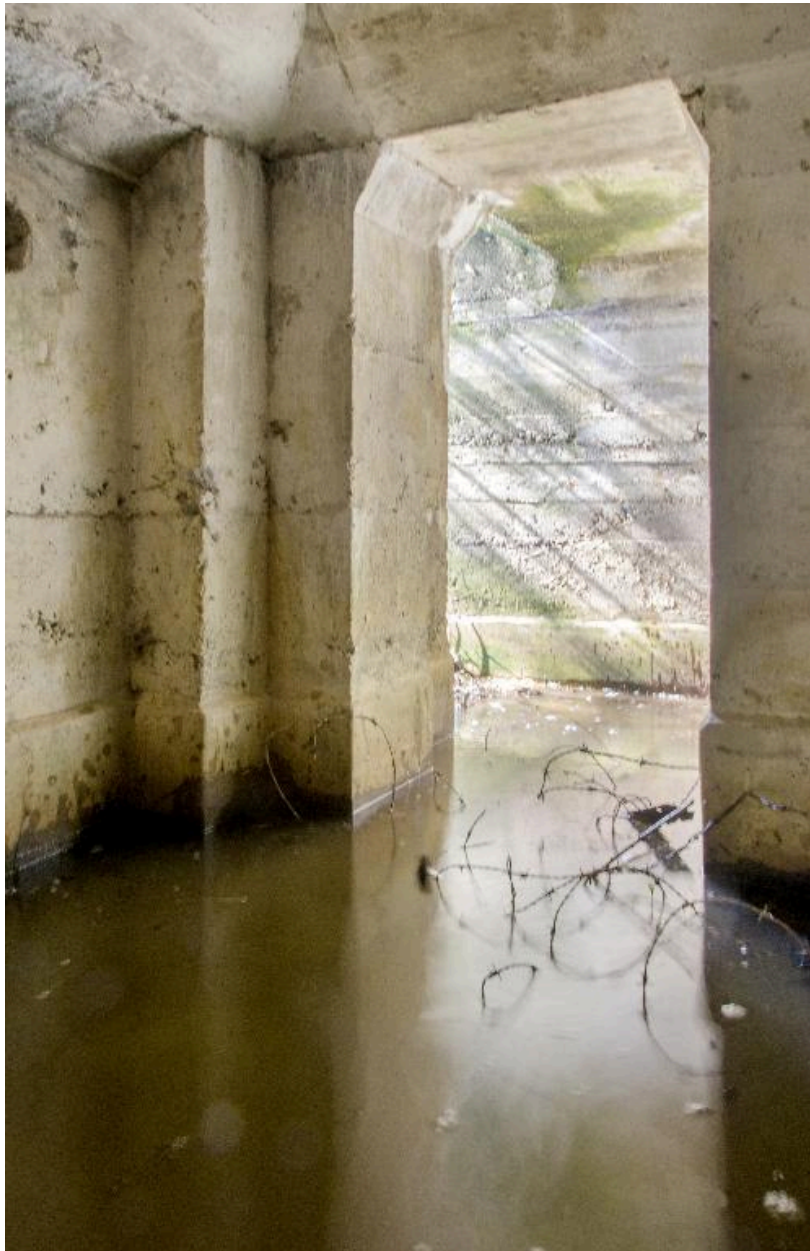
Vue intérieure vers l'entrée ouest
