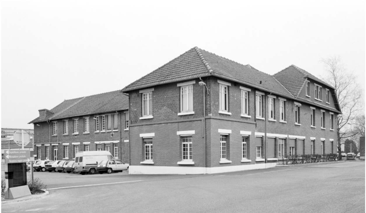
Vue des bureaux et de la réception, depuis le sud-ouest.
