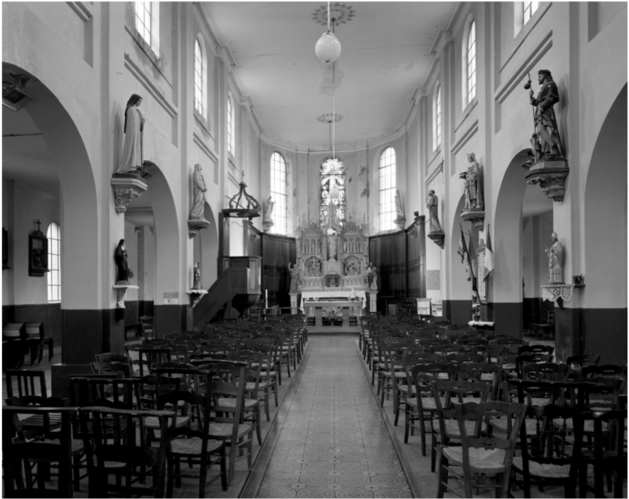
Vue intérieure depuis l'entrée vers le chœur.
