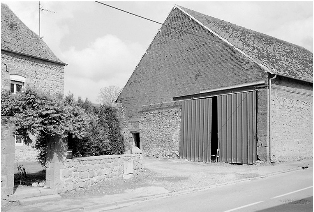
Vue de la grange, depuis la voie.
