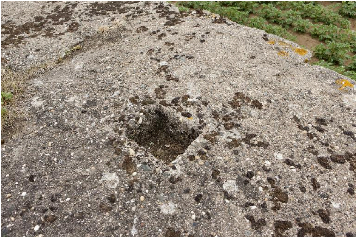
Couvrement, détail d'un conduit de cheminée obstrué
