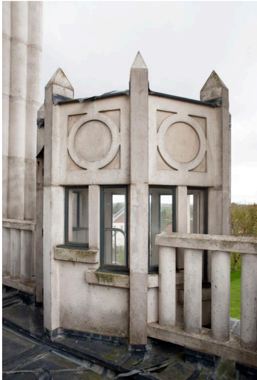
Lanterne de la tourelle d'escalier du clocher.
