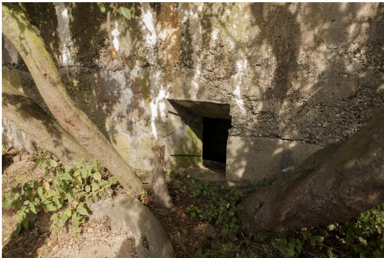
Ouverture dans l'élévation sud
