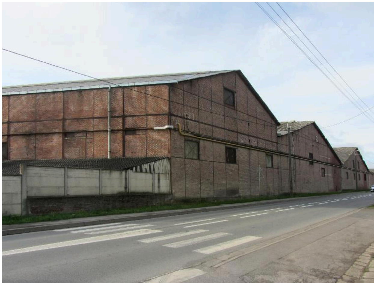
Pignons sur rue des ateliers de fabrication.
