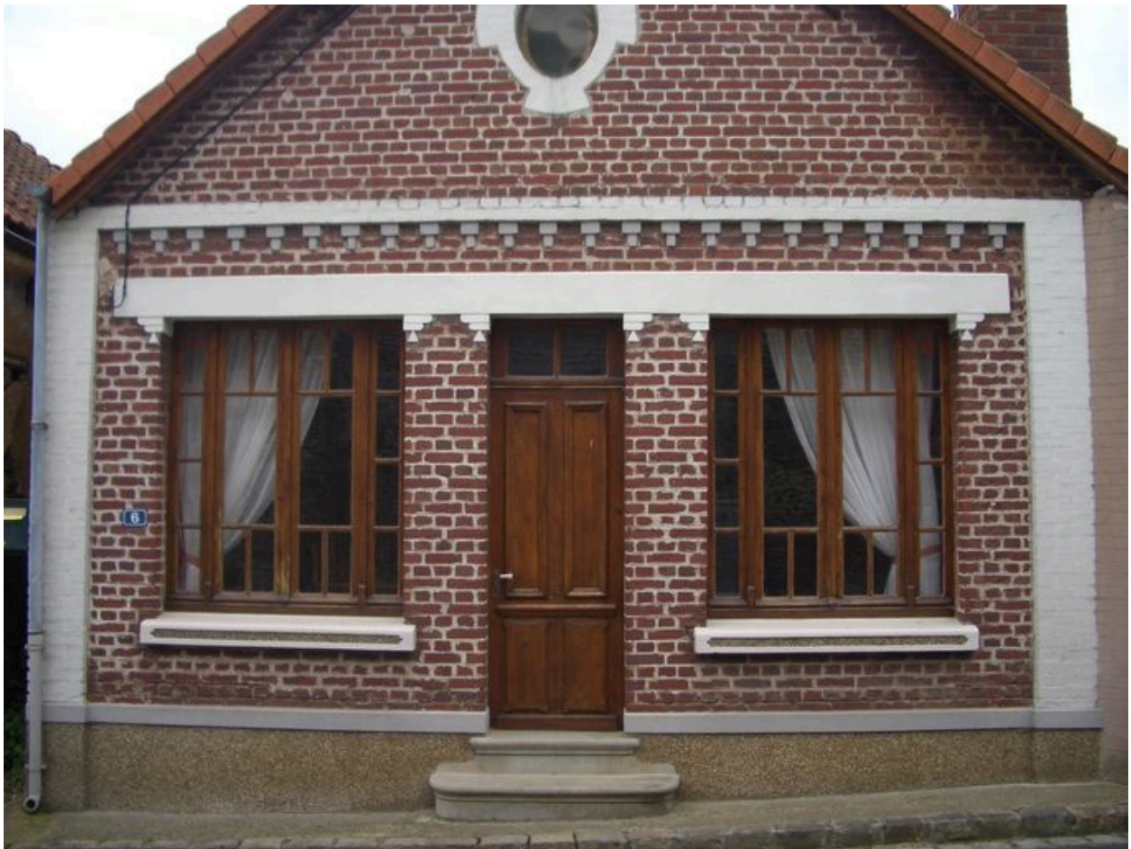
Vue de la face principale du logis.
