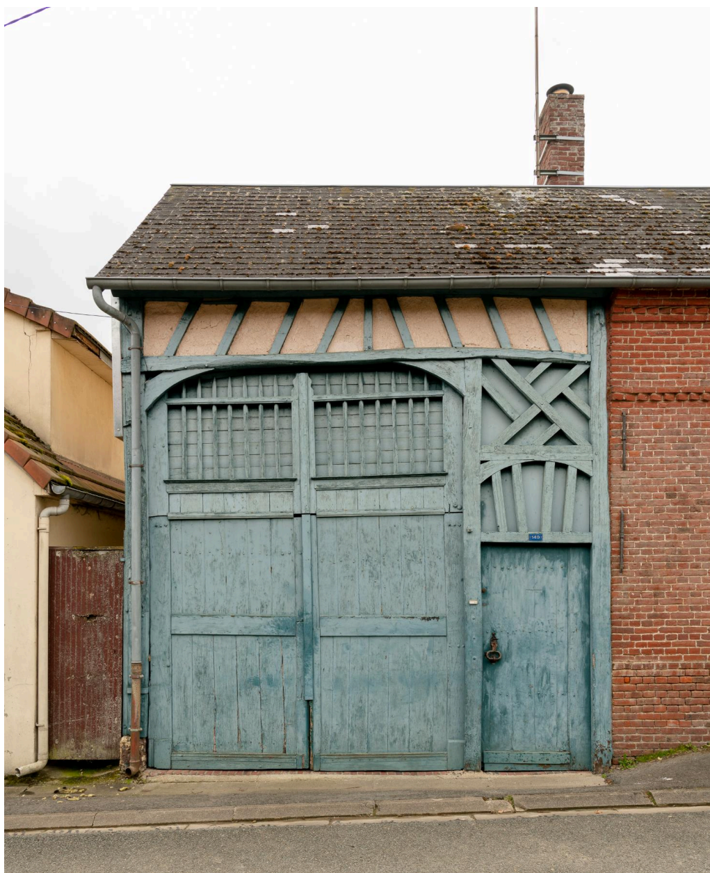
Entrée charretière, n°149 de la rue de l'Abreuvoir, vue prise depuis le nord.
