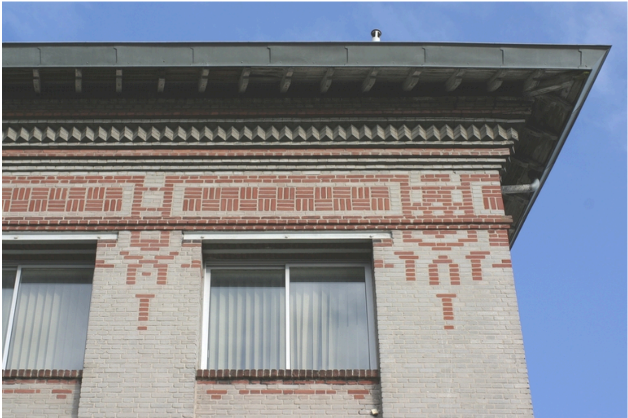
Détail de la façade, rue de la Tour-Sainte-Catherine.
