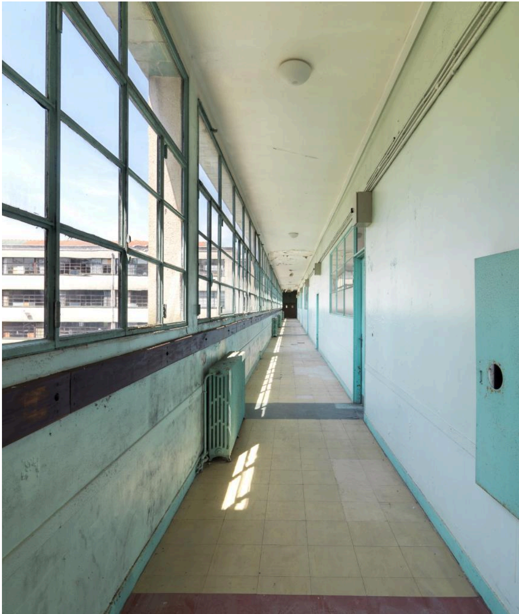
Couloir de distribution des salles de classe du premier étage.
