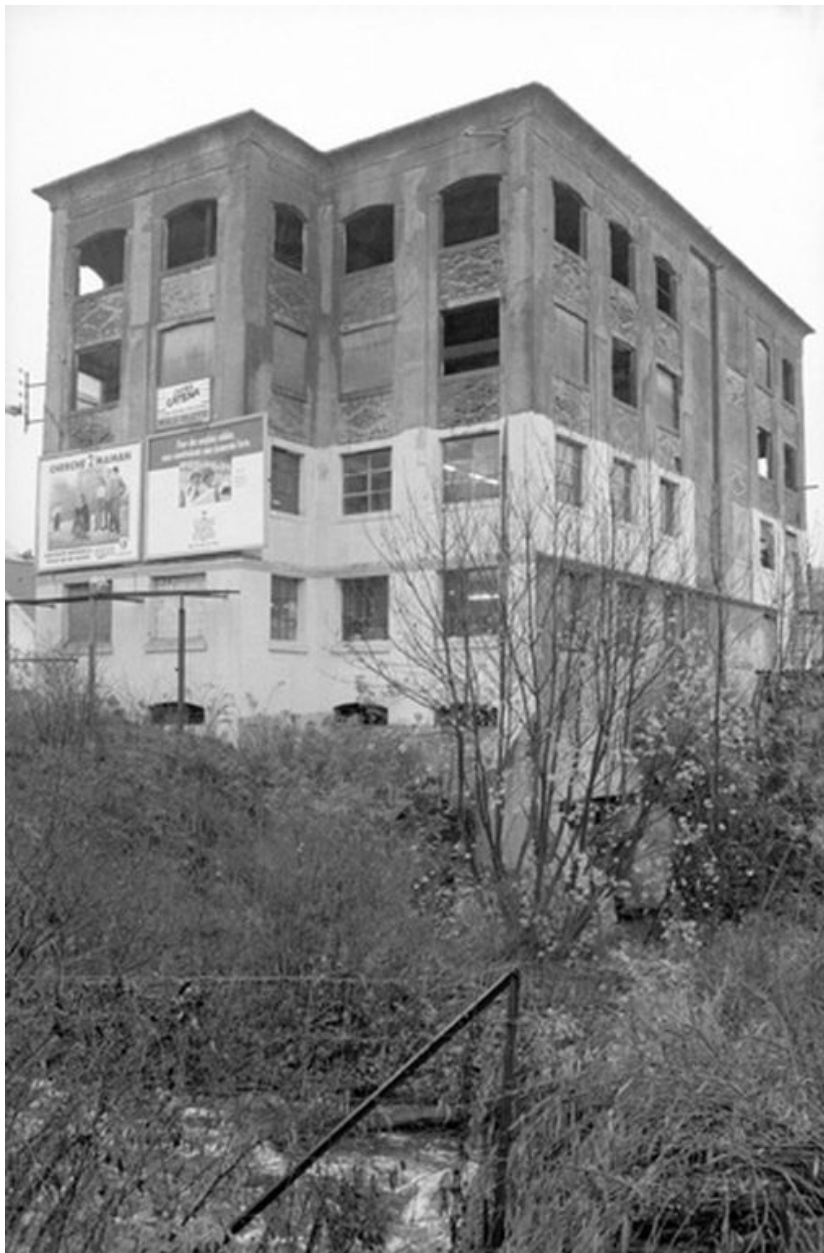
Vue d'ensemble, flanc nord ouest.
