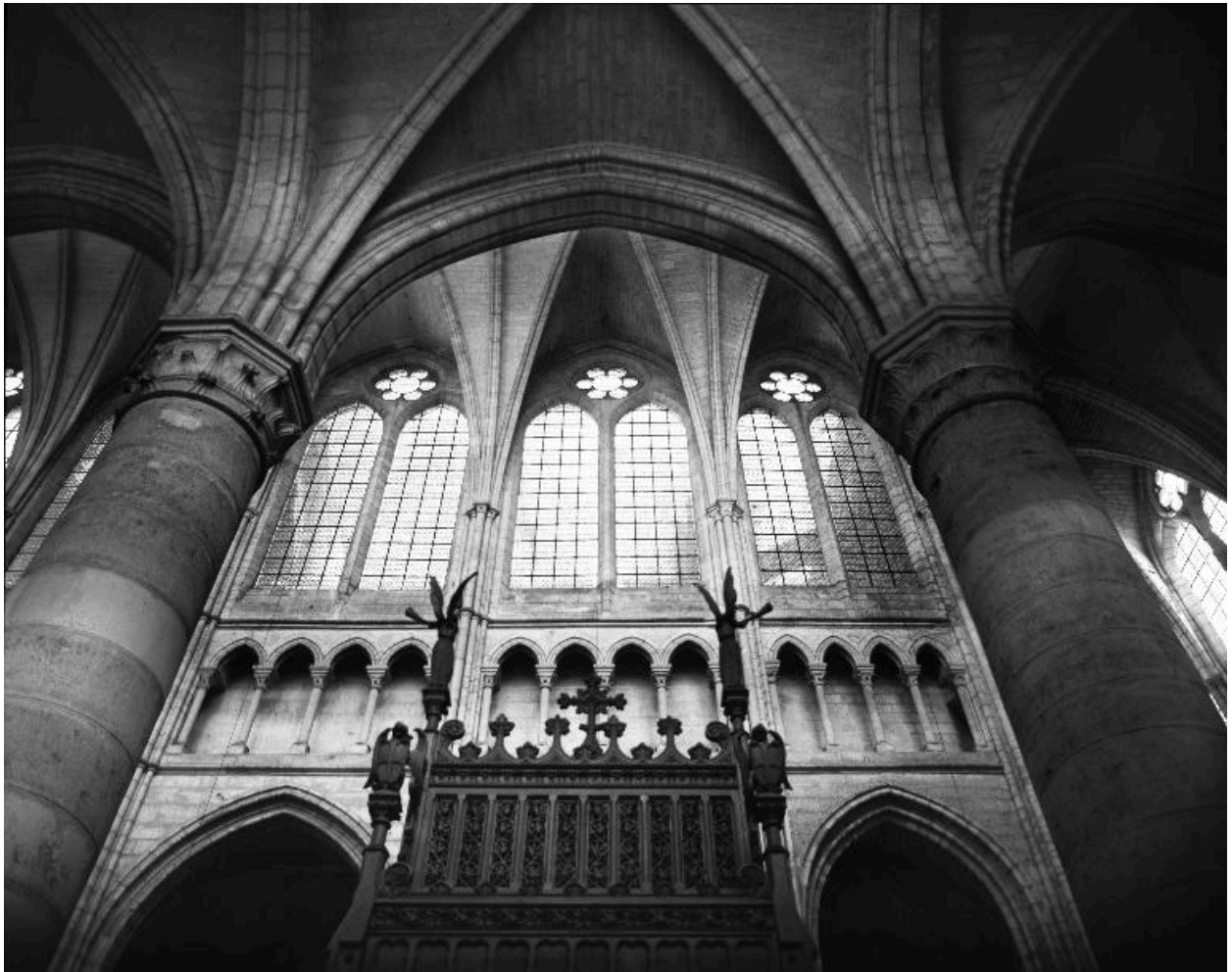
Détail du triforium et des fenêtres hautes du côté nord de la nef
